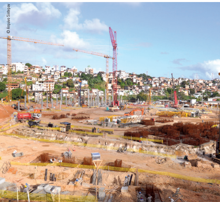
Construção da Arena Fonte Nova
