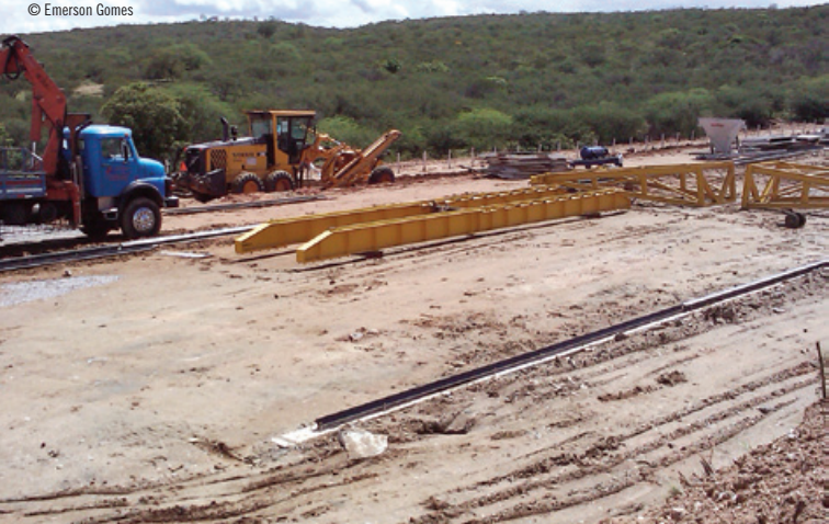
Obra da Ferrovia da Integração Oeste Leste
