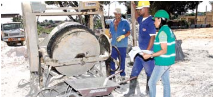
A técnica de segurança do trabalho do Sintepav-Ba, Cleide Sousa, durante inspeção nas obras
